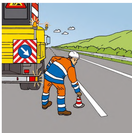
Figura 44 – Chiusura della corsia di sorpasso: inizio della posa dei coni
